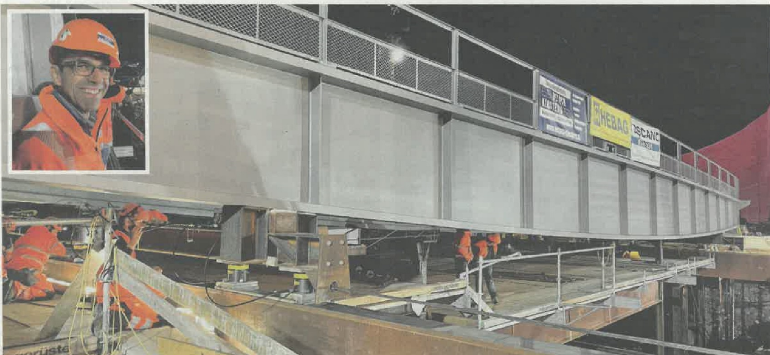
Bauunternehmer Roger Vetsch beobachtet die Einschiebung der neuen Schlappinbach-Brücke (425 Tonnen).
