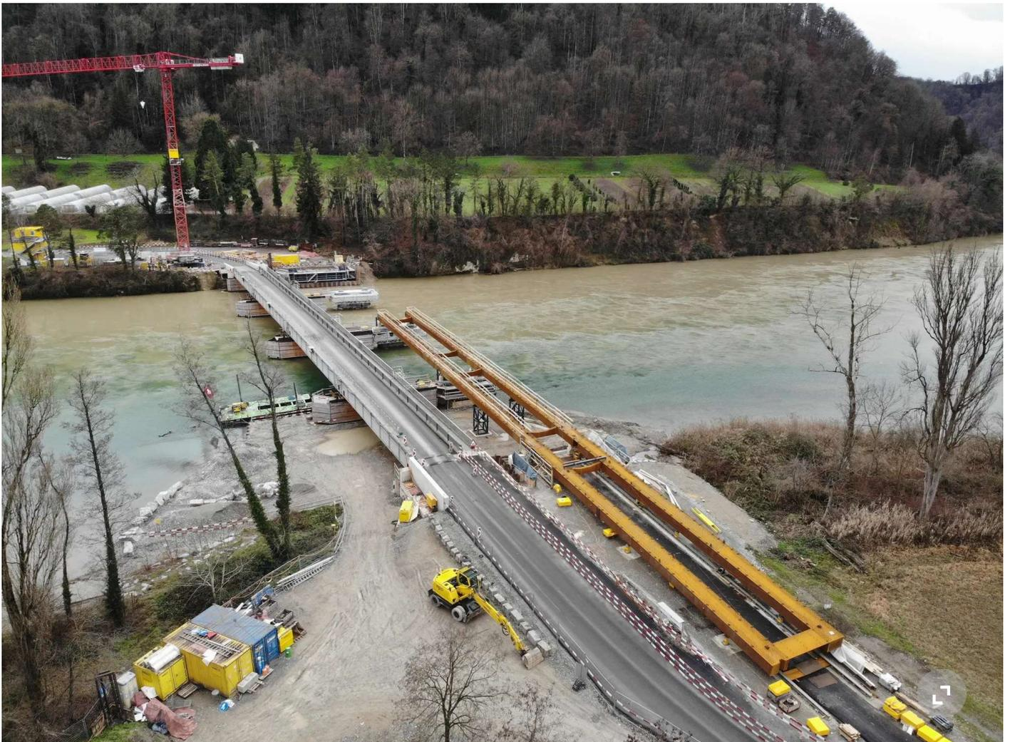
Aufnahme vom 24. Dezember 2022: Links ist die alte, flussaufwärts verschobene Rheinbrücke zu sehen, rechts die neue, sich im Bau befindliche Brücke. Das gelbliche Bauteil ist der Überbau aus Stahl.
