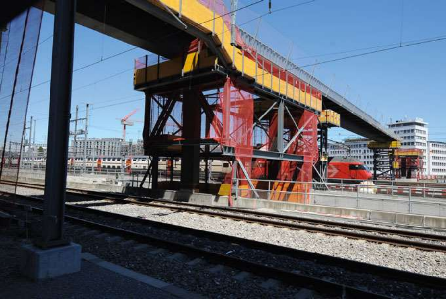
Die in Stahl gefertigte Brückenkonstruktion...
