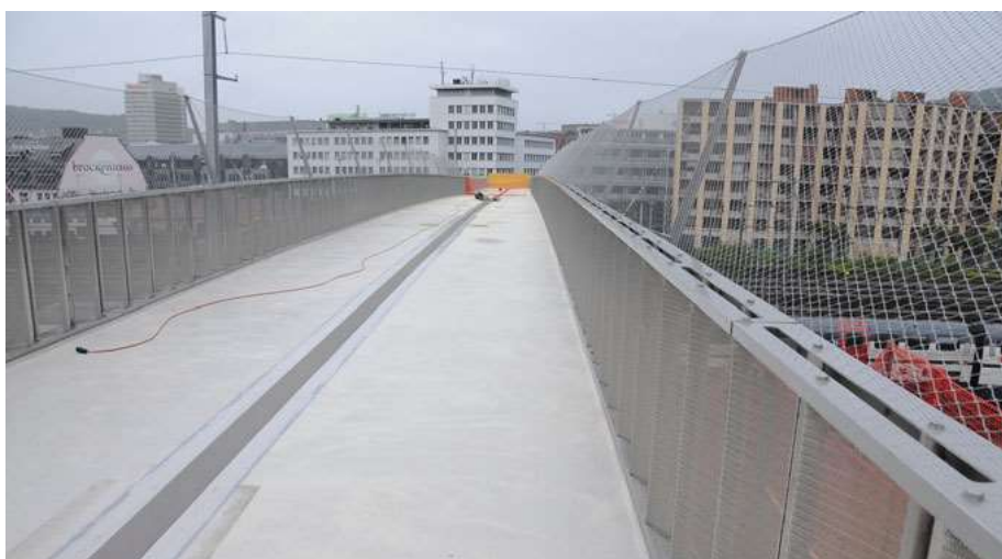
Der Negrellisteg überquert auf 160 Meter Länge das Gleisfeld vor dem Zürcher Hauptbahnhof.
