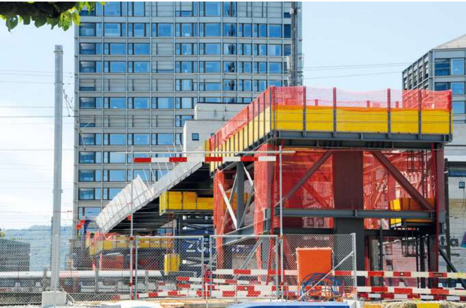
...wird Stück für Stück in Nachtzugspausen über das Gleisfeld eingeschoben.
