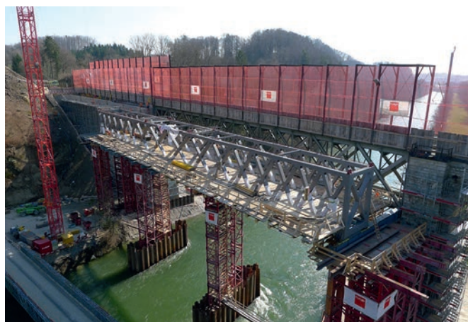
Bild 8 Saanequerung vor dem Erstellen des Schottertrogs aus Beton Bridge over the Saane before the concrete slab is built
