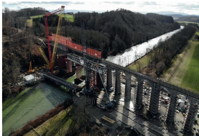
Bild 7 Montage Stahlfachwerk auf provisorischen Gerüsttürmen Assembly of the steel girder on temporary scaffolding towers
