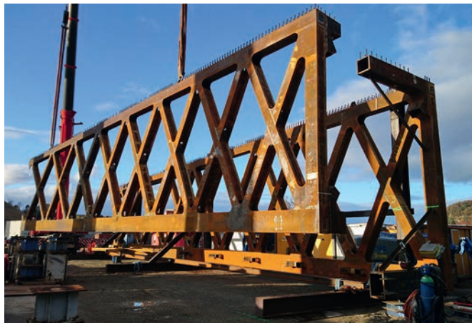
Bild 5 Vormontage des Stahlfachwerks Pre-assembly of the steel girder
