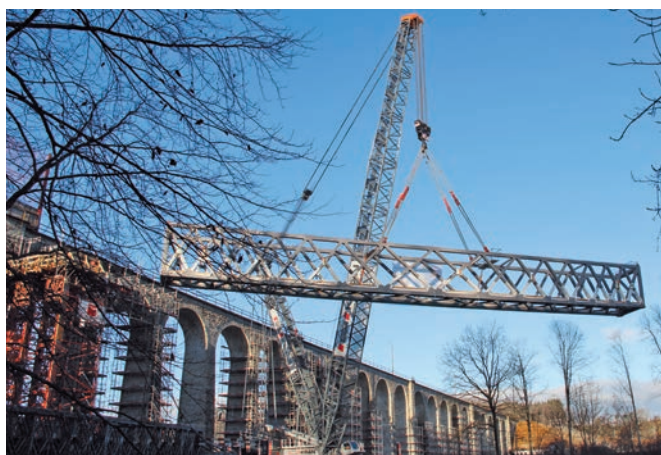
Bild 6 Hub der neuen Saanequerung Lift of the new bridge over the Saane
