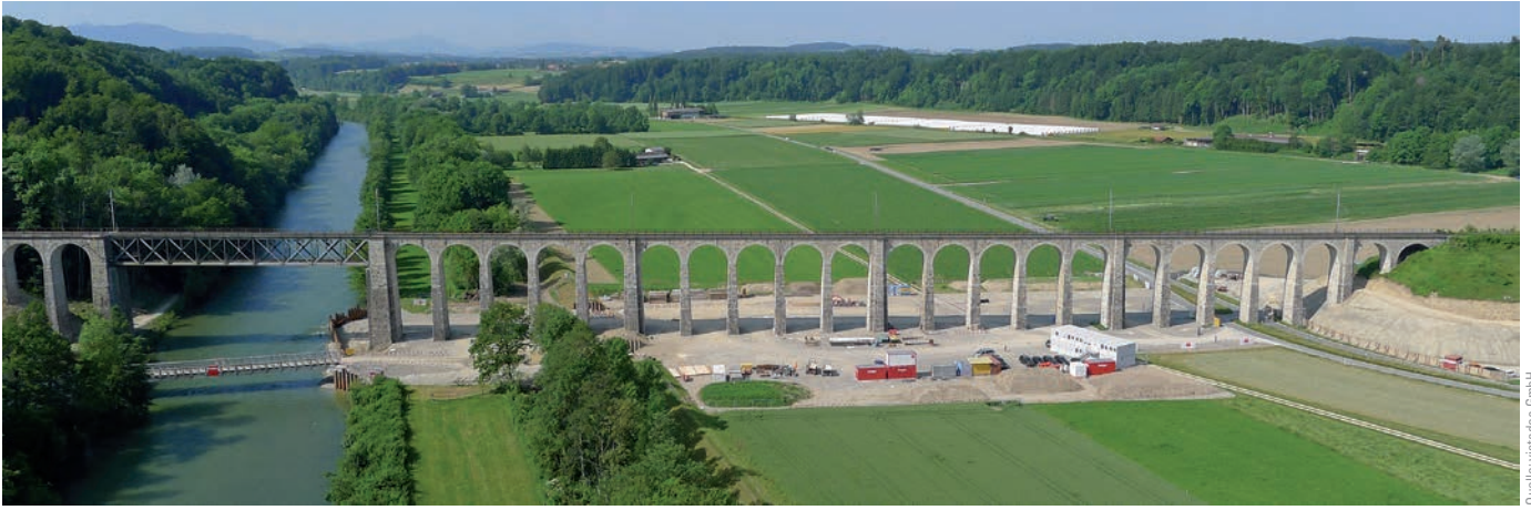
Bild 1 Saaneviadukt: Blickrichtung Süden Saane viaduct: view direction south
